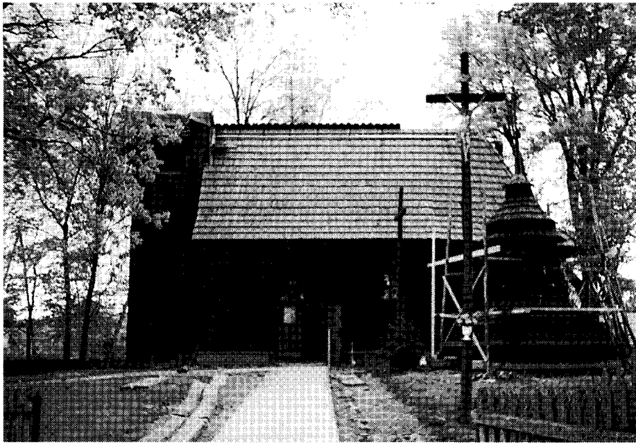
Das neue Dach und das Turmoberteil fertig zum Aufsetzen mit dem Kranwagen.
